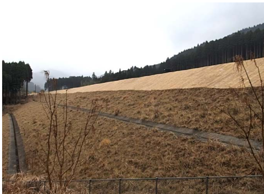
図 2.1 盛り土によって作られた東九州道。
