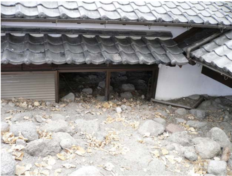
図 2.6 土石流によってほとんど埋没した家屋。
