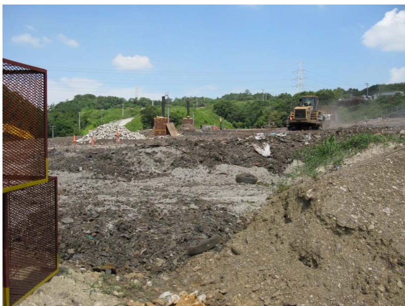
図 2.7 シュレッダーダストを受け入れている廃棄物処分場.
